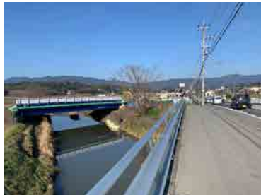
市道幹1009号線 新宿橋周辺
